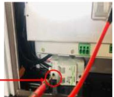
Negativer Anschluß bei Sicherung
